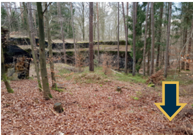
Standort-Foto Entdeckerpunkt am Bw 91
