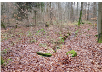
Standort-Foto des Entdeckerplatzes am Einlaufbauwerk 81
