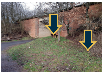
Standort-Foto Entdeckerpunkt am Bw 149
